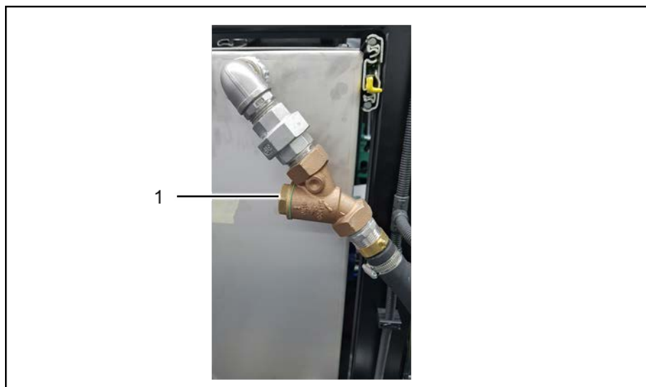
Рис. 25: фильтр грубой очистки резервуара подачи воды
